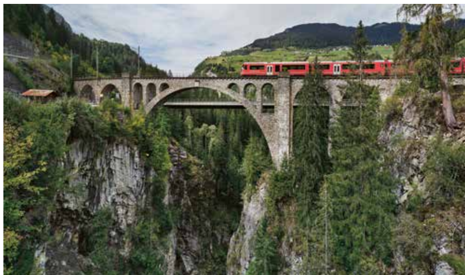
Ähnlich klimaschädlich wie der Autoverkehr: Soliser Viadukt über der Albula.
